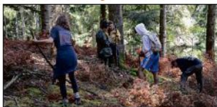
Le chantier de Saint-Amant-Roche-Savine fait partie des 15 chantiers du département cet été.
